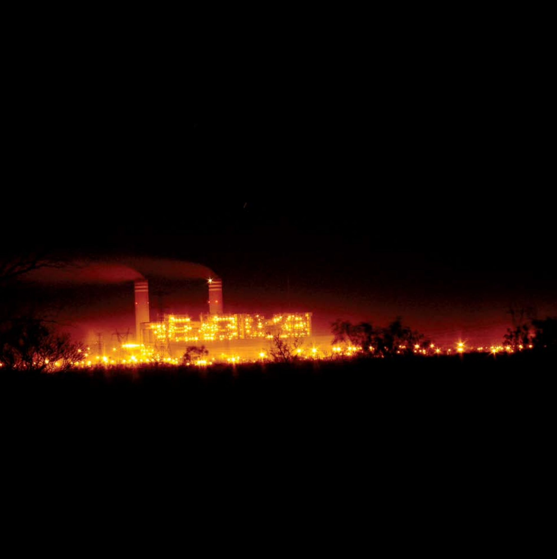
Planta Termoeléctrica de Río Escondido (CFE), Nava, Coahuila. Mayo de 2006
